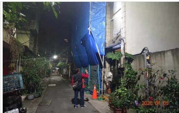
新建工地巡邏
